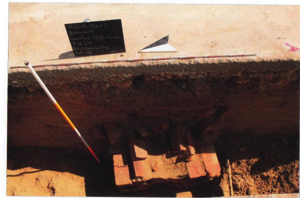
Abb. 5: Die Ringmauer im Bereich der Moosburger Straße. Deutlich ist die Schalenbauweise mit Außenschalen im Blockverband erkennbar. Die oberen Ziegel sind in Richtung der mit Sand verfüllten Mauermittel verstreut (Foto: Kreisarchäologie Landshut).
