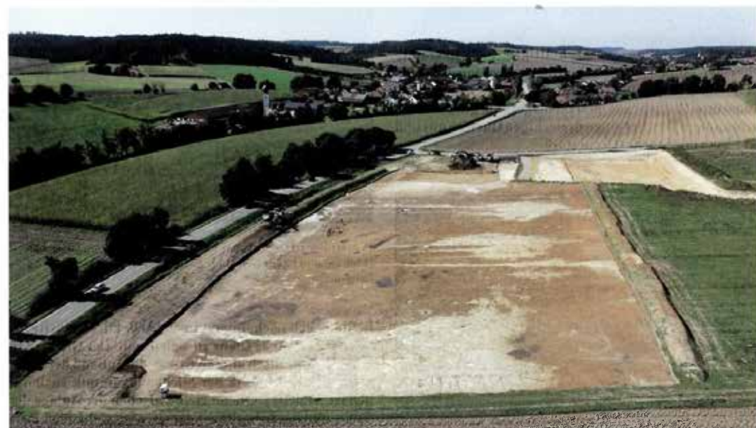
11 Spitzlberg. Blick von Süden über die Grabungsfläche der Deponieerweiterung in das tertiäre Hügelland. Im Hintergrund die Ortschaft Unterglain. Die bestehende Reststoffdeponie schließt am Bildrand rechts an.
